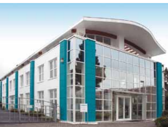
Die Airnergy-Firmenzentrale in Hennef bei Bonn ist Service-, Schulungs- und Produktionsstandort zugleich.
